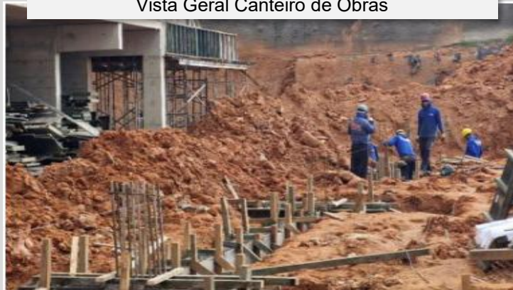
Vista Geral Canteiro de Obras
