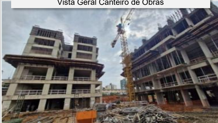
Vista Geral Canteiro de Obras
