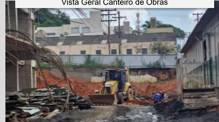
Vista Geral Canteiro de Obras
